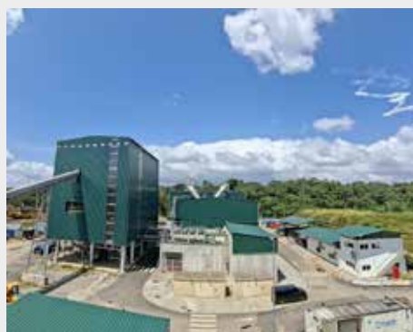
Centrale biomasse de Sinnamary (Guyane)
