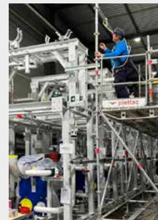
Opérateur effectuant une opération d'assemblage sur une station hydrogène.
