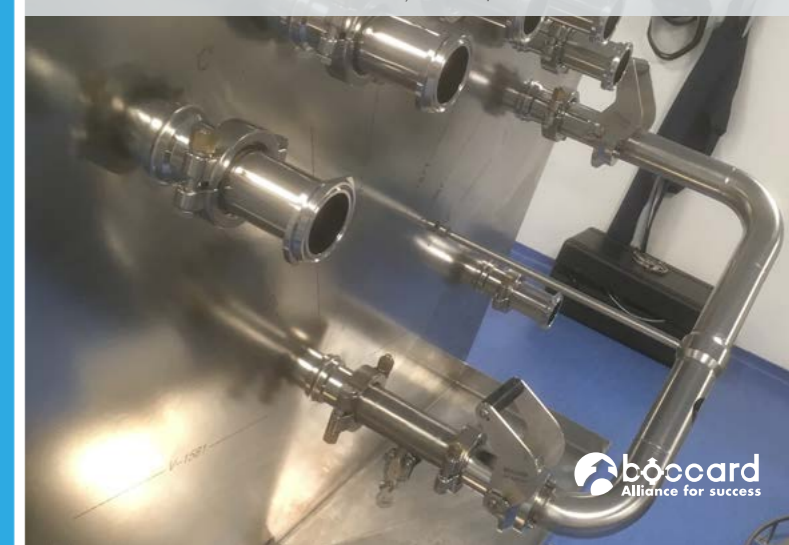
Оригинальная панель перекачки преобразована в версию Boclock (с использованием клампов / Boclock)
